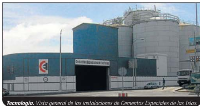
Tecnología. Vista general de las instalaciones de Cementos Especiales de las Islas.
